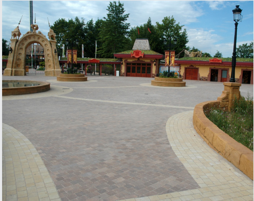
Der neu gestaltete Eingangsbereich des Holiday Parks in Hassloch versetzt Besucher dank einer ganz bewussten Art der Flächenbefestigung von Anfang an in die richtige Freizeitstimmung. (Foto: Betonwerk Pfenning GmbH)
