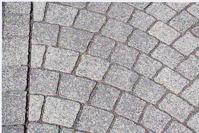
Bild 3: Sauberer Randabschluss: Verlegt man als Randbegrenzung einen Einzelstein des Steinsystems ArcoStrada als „Läufer“, so lassen sich die Bogensteine sauber anlegen – der Schneideaufwand hält sich dabei in Grenzen (Foto: Betonwerk Pfenning GmbH)
