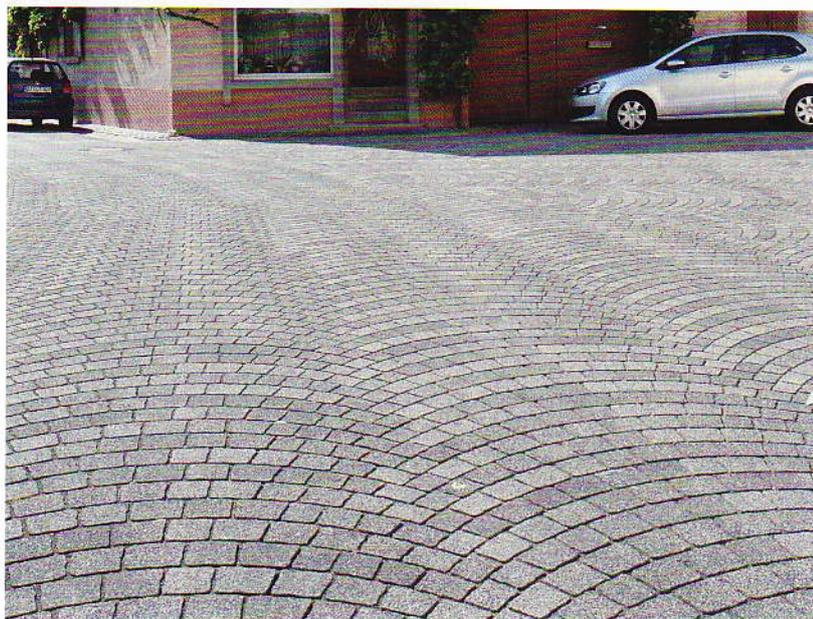
Die Entscheidung für das zu verwendende Material fiel auf ein speziell für derartige Anwendungsfälle entwickeltes Pflastersystem aus Beton. Das Arco-Strada-Segmentbogenpflaster aus der CombiStabil-Produktfamilie des Herstellers Beton Pfenning aus Lampertheim verbindet die attraktive Optik eines in Segment-
