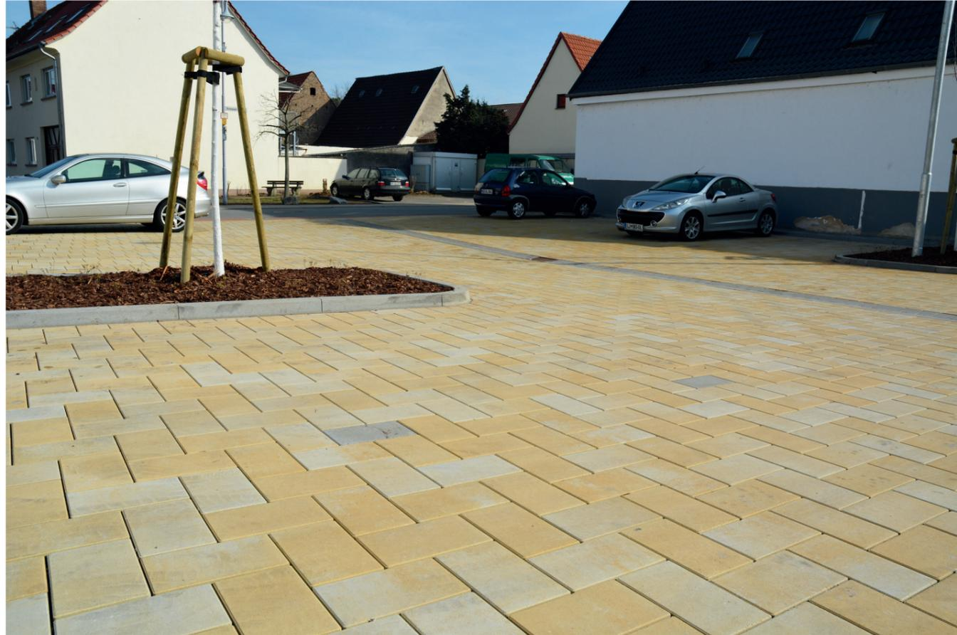
Lupenrein: Gemäß der DIN 18318 ergeben sich bei dem Steinsystem COMBICONNECT stets normgerechte Fugenbreiten von 4 mm. (Foto: Beton-Pfenning)
