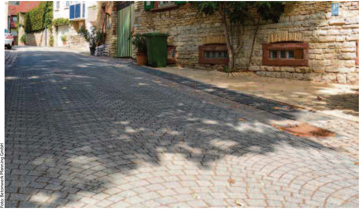
Nachher: Das Segmentbogenpflaster ArcoStrada verbindet die attraktive Optik eines Kleinpflasters mit den Vorteilen eines Betonpflasters.
