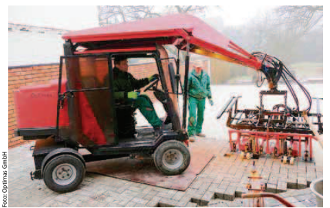
Die Optimas H 88 Verlegemaschine arbeitet bodenschonend und entlastet die Mitarbeiter.
