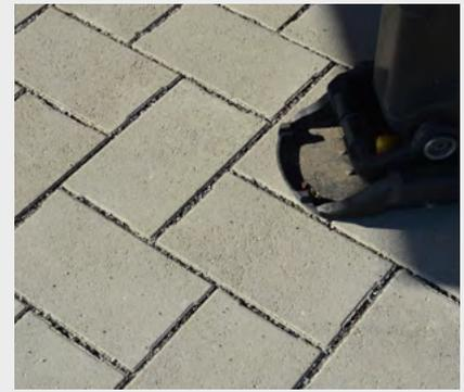
Für die Auflieger-Stellplätze entschieden sich die Planer für das versickerungsfähige Pflastersystem HydroStabil. Dank seiner Verbundelemente gilt es als verschiebesicher. An den Kopfseiten der Steine verfügt das System über Wasserspeicher-Kammern. Im Falle eines ergiebigen Regengusses wird hier das einlaufende Oberflächenwasser vorgespeichert und danach zügig an Ober- und Unterbau weitergeleitet. (Foto: Beton-Pfenning)
