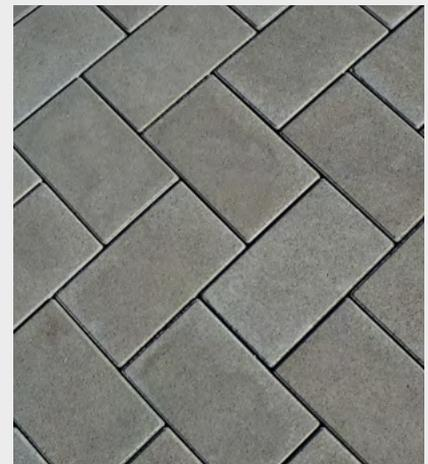
Im verlegten Zustand ist das werkseitig fixierte, steinumfassende EPDM Profil kaum zu erkennen. (Foto: Beton-Pfenning)
