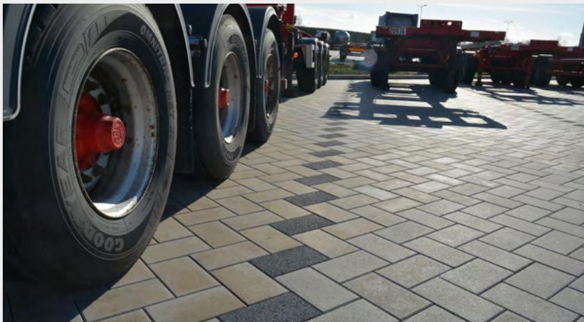
Schwerlastpflaster für schwere LKW: Die LKW-Stellplätze des neuen Umschlagslagers bei der Spedition Peter Hempt in Worms wurden mit dem Pflastersystem COMBICONNECT gepflastert. (Foto: Beton-Pfenning)
