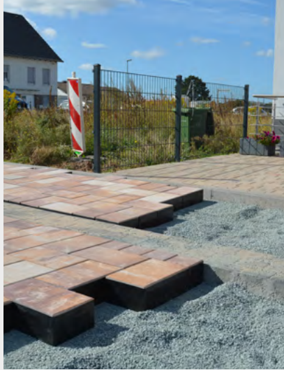
Es muss nicht immer Sand oder Splitt sein: beim Pflastersystem COMBICONNECT aus dem Hause Beton Pfenning wird die Fuge aus EPDM gebildet. (Foto: Beton-Pfenning)
