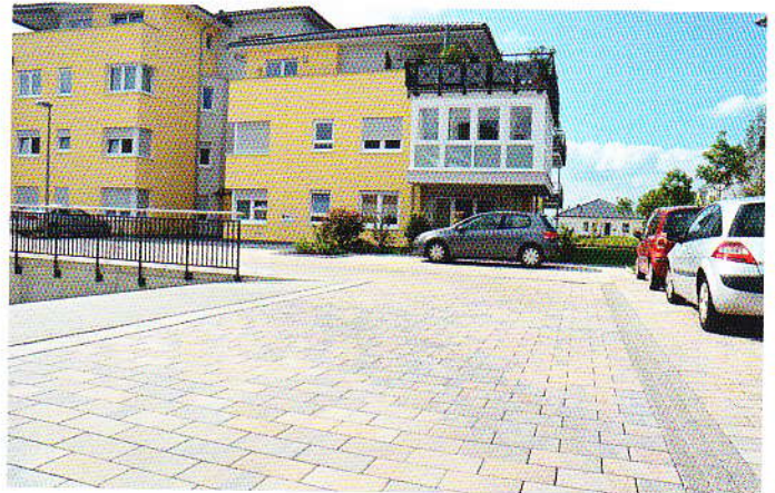
Auch die Zufahrt zur Tiefgarage und die Befestigung der Parkplätze erfolgte durch ein Pflastersystem mit spezieller Verbundtechnologie. Zum Einsatz kam hier CombiStabil im Farbton muschelkalk.
