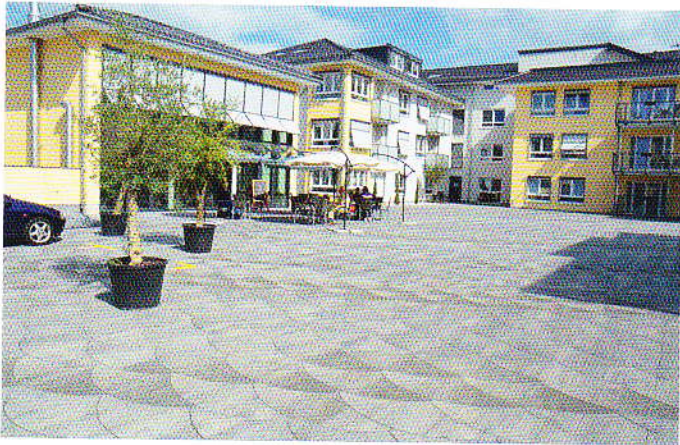
Dank der Bogenform des Betonpflasters ArcoSwing, erfolgt ein harmonischer Übergang von den gelben Fassaden auf die Hoffläche.
