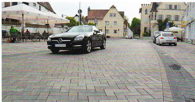
Bild 1: Nach der Sanierung wirkt der Straßenraum offen und aufgeräumt (Fotos: Einstein Fugentechnik)
