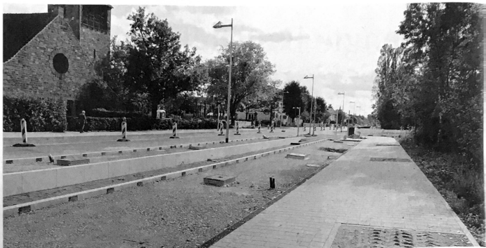
Die „Waldpforte“ ist einer von zahlreichen Straßenzügen, bei denen es im Rahmen des Großprojekts „Stadtbahn Mannheim Nord“ zu einer kompletten Neuordnung des Straßenraums kam. FOTO: BETONWERK PFENNING
